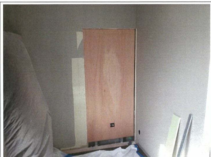
洗面ユニット後部補強ベニヤ
