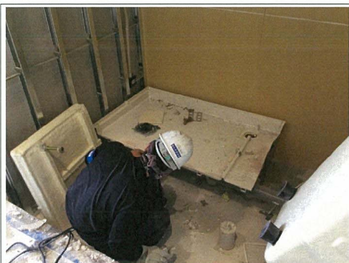
既設UB解体
