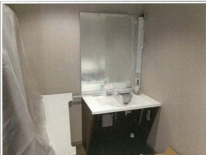
洗面ユニット設置
