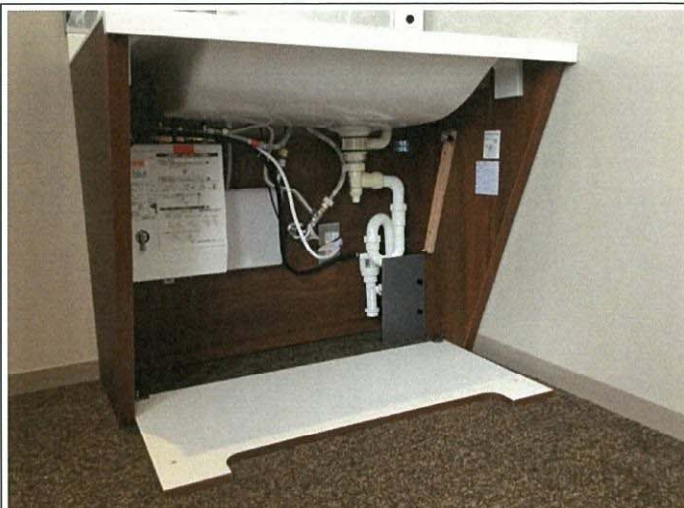
洗面ユニット配管完了
