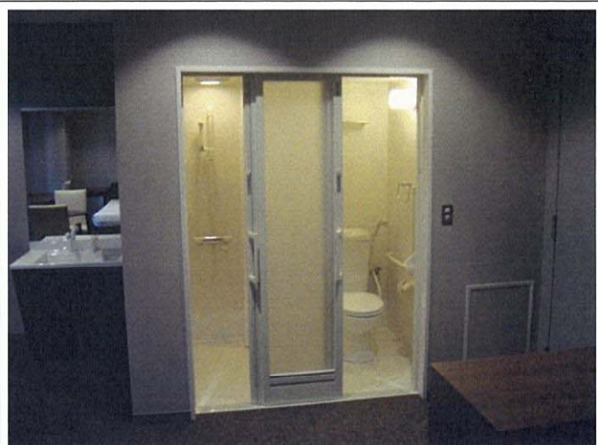
完成ユニット
