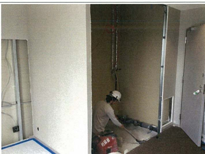
解体完了清掃
