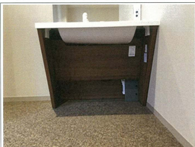
洗面ユニット配管完了
