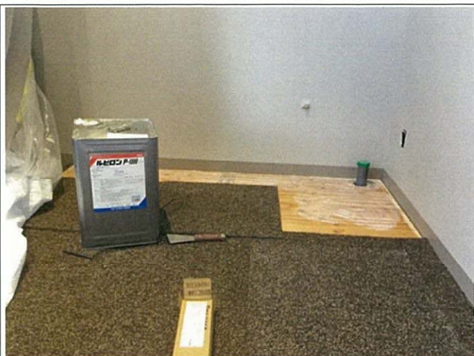
カーペット貼り
