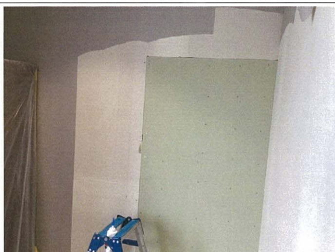
洗面ユニット後部補強部耐水石膏ボード貼り
